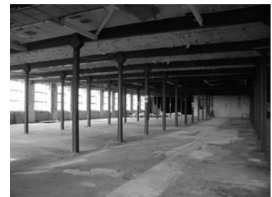
Blick in die Leipziger Ausstellungsräume, während der Bauphase Mitte März.
